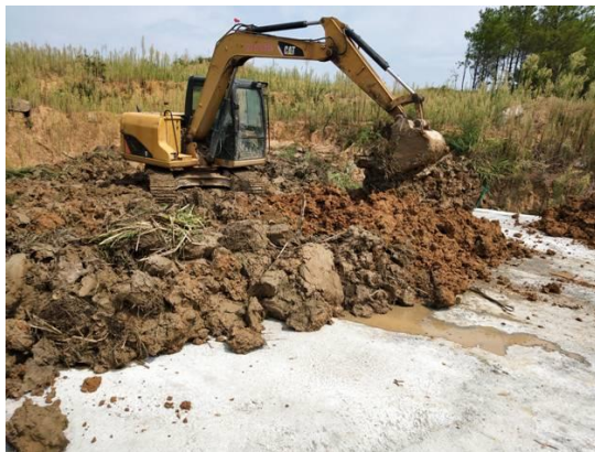
图 6-5 污水池占地覆土复貌 (1)
