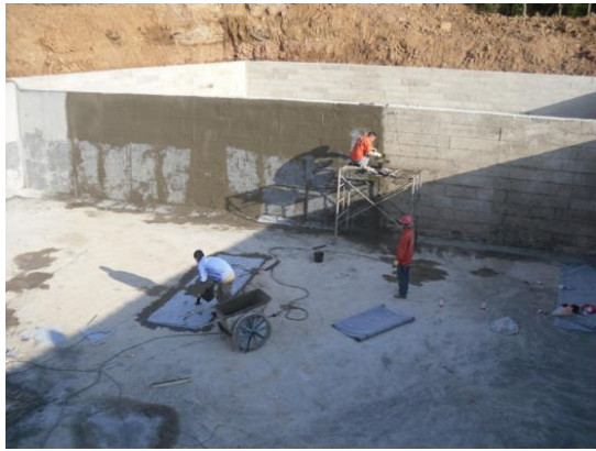
图 6-1 废水池池内防渗 (1)
