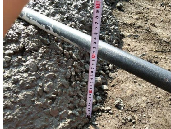
图 6-4 废水池浇筑混凝土封盖 (2)
