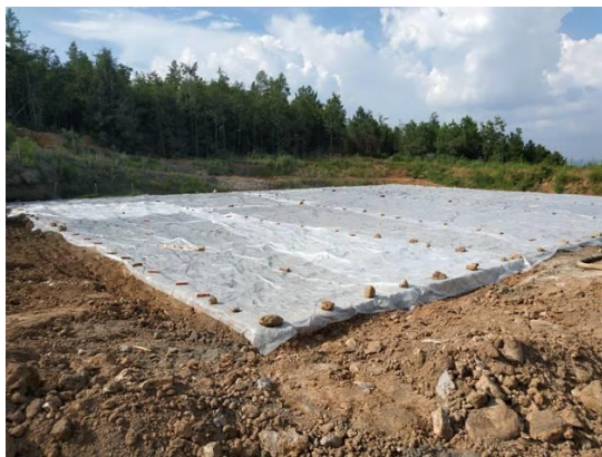
图 6-3 废水池浇筑混凝土封盖 (1)
